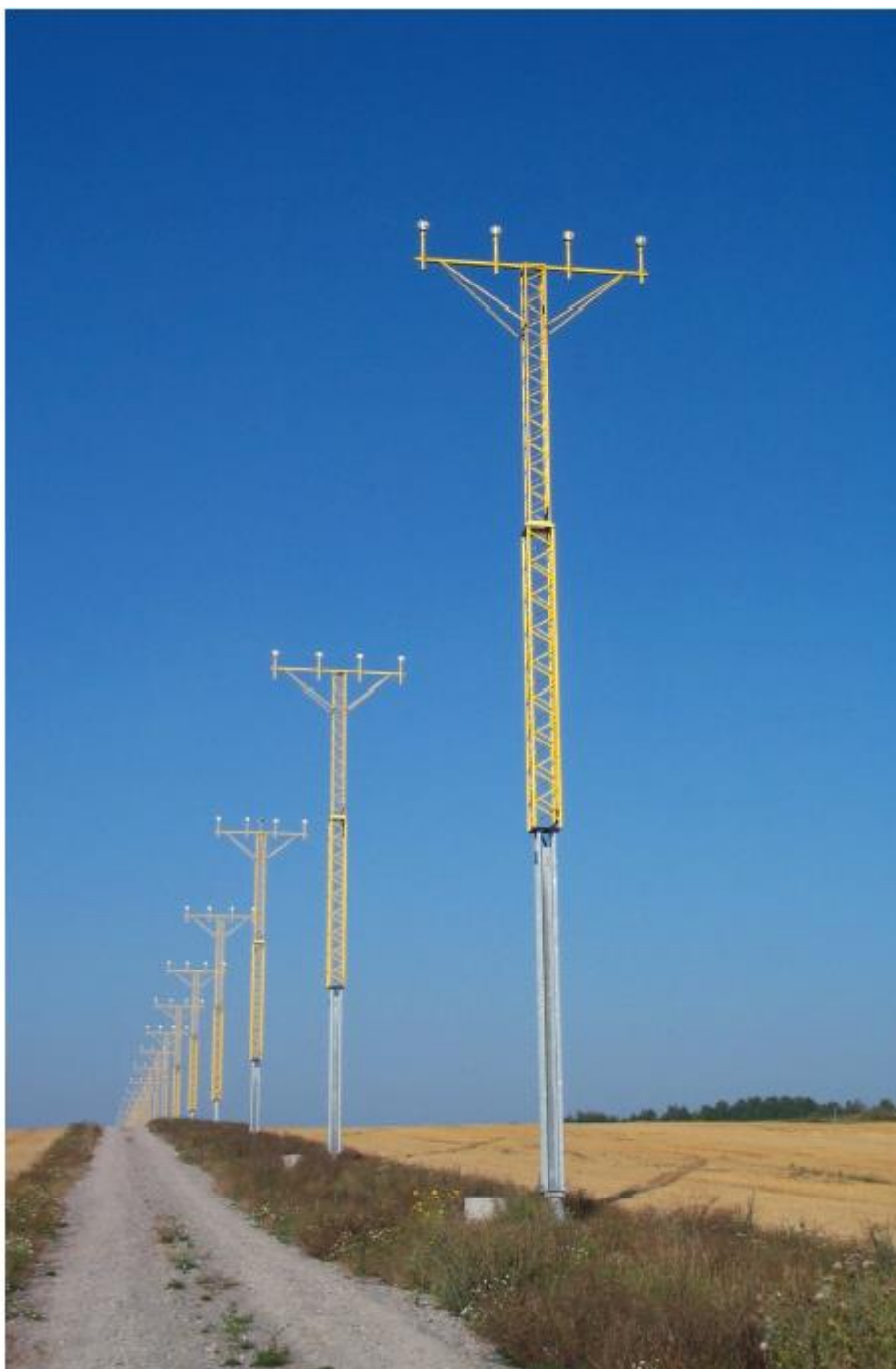
Рис. 4-8. Стеклопластиковые опоры огней приближения на жестких поддерживающих конструкциях
