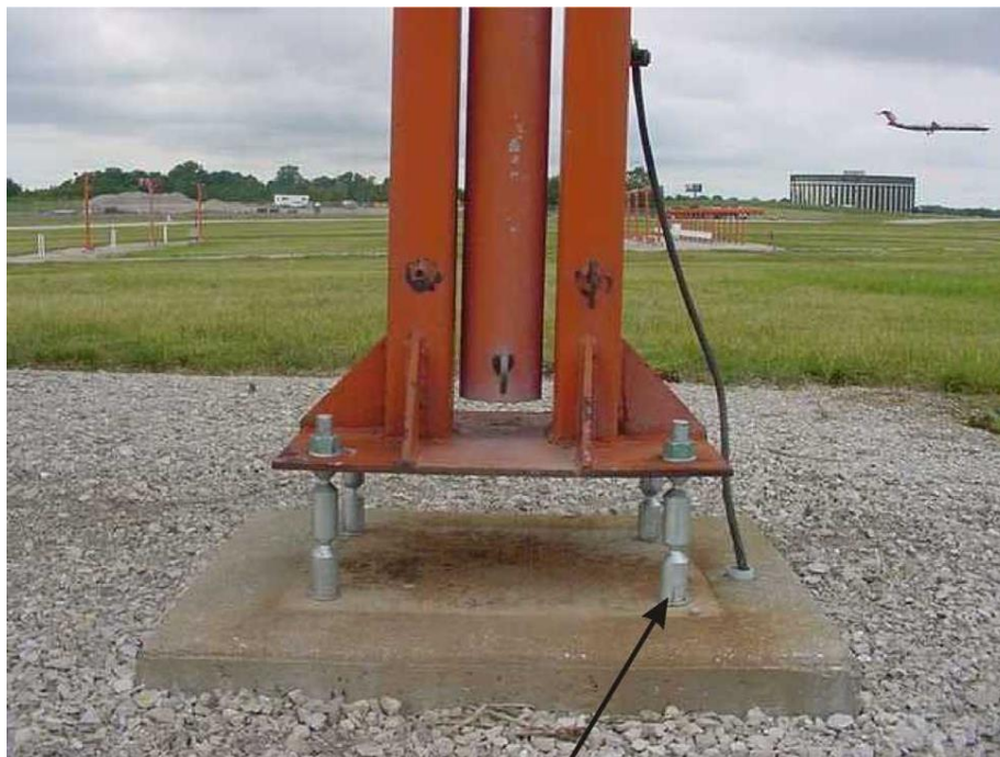
Рисунок 4-1. Болт предохранителя.
