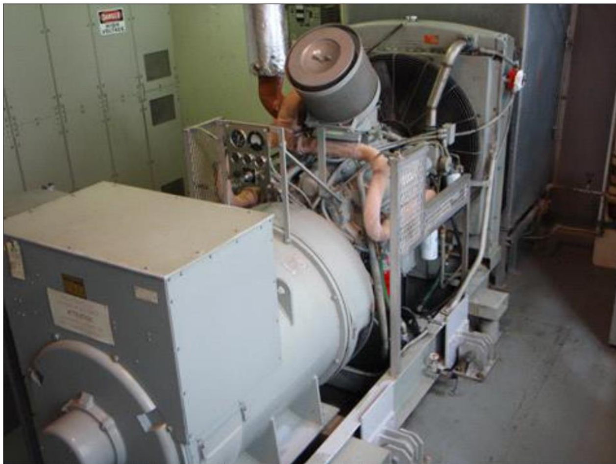
Рис. 3-7. Установка дизель-генератора
