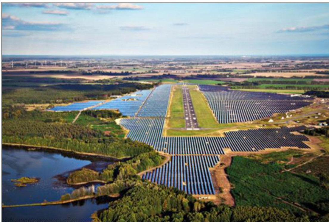
Рис. 3-1. Солнечная установка. Аэропорт Нойхарденберг (Германия), 1,4 МВт.
